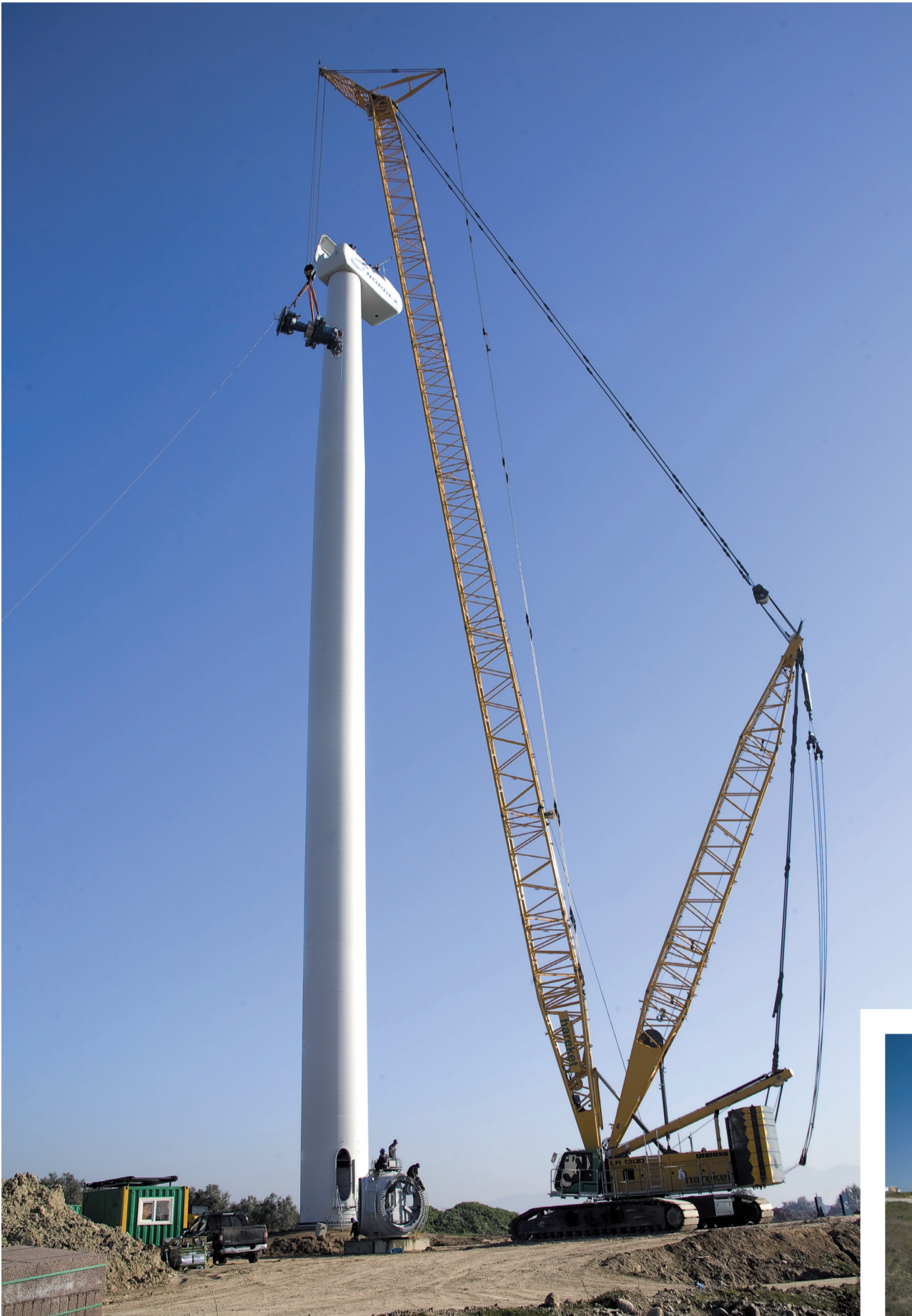
Liebherr LR 1300 SXW daralan paletli vincin kullanıldığı Susurluk projesinden bir görüntü
